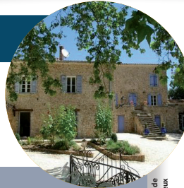
*Mairie de Méounes-lès-Montrieux
